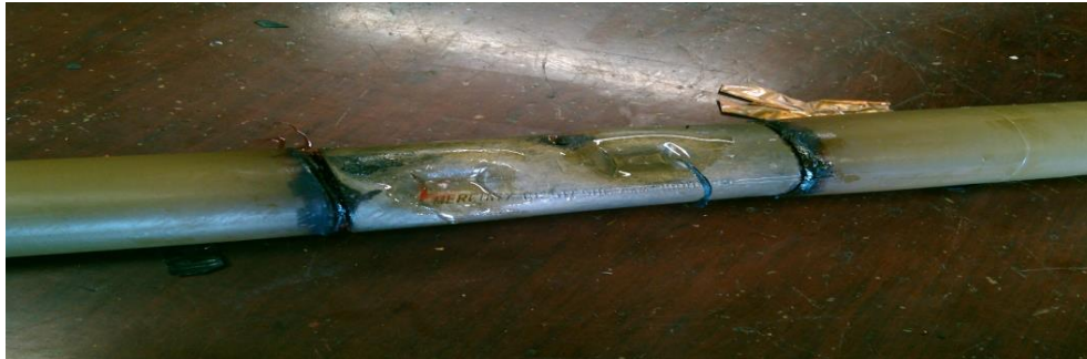
Fig. 1.13 Fotografías del interior del empalme donde se evidencian los daños que causaron la incidencia acústica detectada por el Ultrasonido Propagado en Aire/Estructuras
