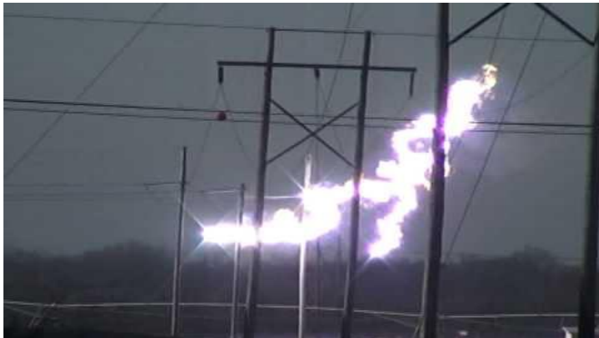
FIGURA 8: DESCARGA DE ARCO ELECTRICO EN LINEAS DE DISTRIBUCION
